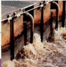
Vorklärbecken, in denen der Schlamm abgesetzt wird.
