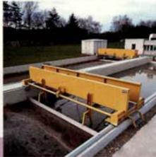
Belüftungsbecken, in dem Mikroorganismen die gelösten Schmutzstoffe abbauen.
