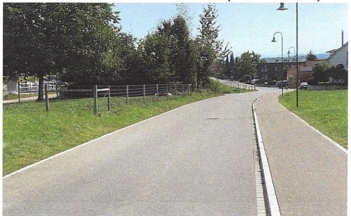
Einfahrt Obere Wallisellerstrasse (Neu Zone 30)
