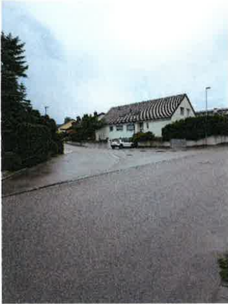
Abbildung 1: Versiegelter Strassenraum im Grossackerquartier
