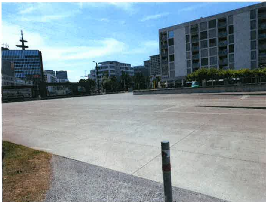
Abbildung 2: Versiegelte Betonfläche im Glattpark
