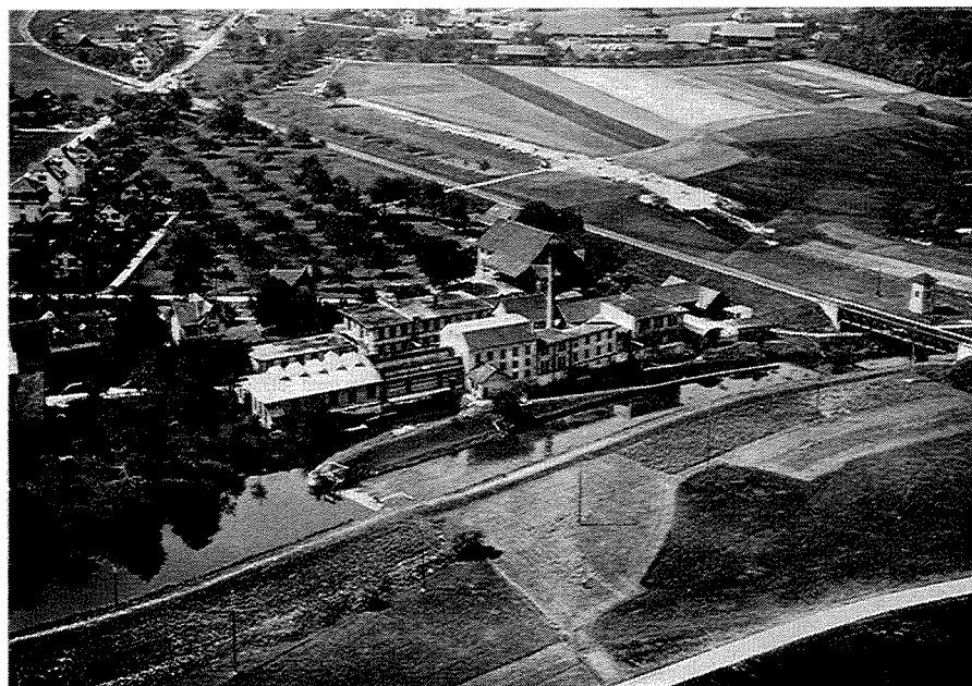
Teppichfabrik Hauser mit Stauwehr in der Glatt, etwa 1930 mit Blick auf das noch offene Feld des «Dreispiß» und des Industriegebietes. Der Abwasserkanal, welcher der Kanalstraße den Namen gab, im Bau begriffen.
