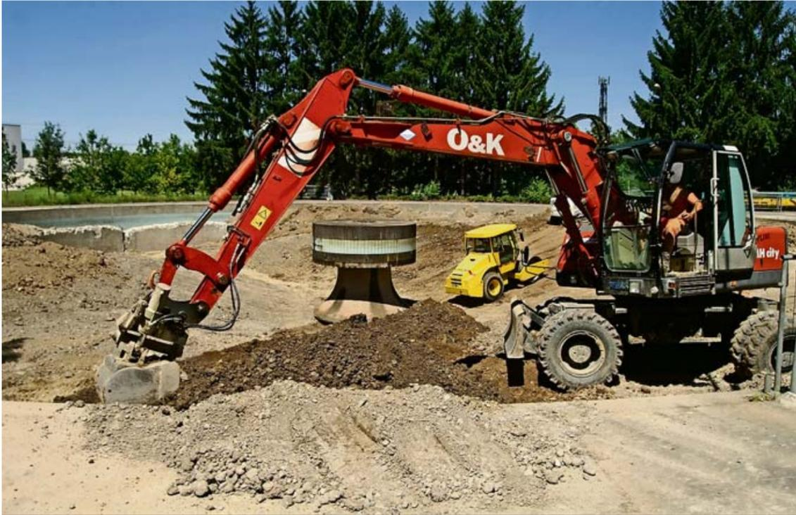
Das westliche Klärbecken wurde teilweise aufgefüllt und wird danach mit Matten abgedichtet. Das Dachwasser der benachbarten Maschinenhalle wird zum Anlegen eines Teiches genutzt. Eine Brücke führt zum Turm.
