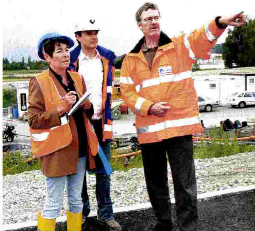
Alex Temperli (rechts), der Verantwortliche für das Baulos «Äussere Thurgauerstrasse», weist Ramon Oppikofer, Ingenieur in der Gesamtprojektleitung, und Christa Huber auf eine der vielen Herausforderungen auf seinem Bauabschnitt hin
