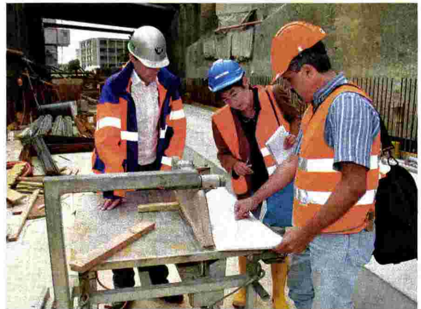
Koordinator Roland Schäfer (rechts) erklärt der Journalistin Christa Huber den Stand der Bauarbeiten im Stelzentunnel.
