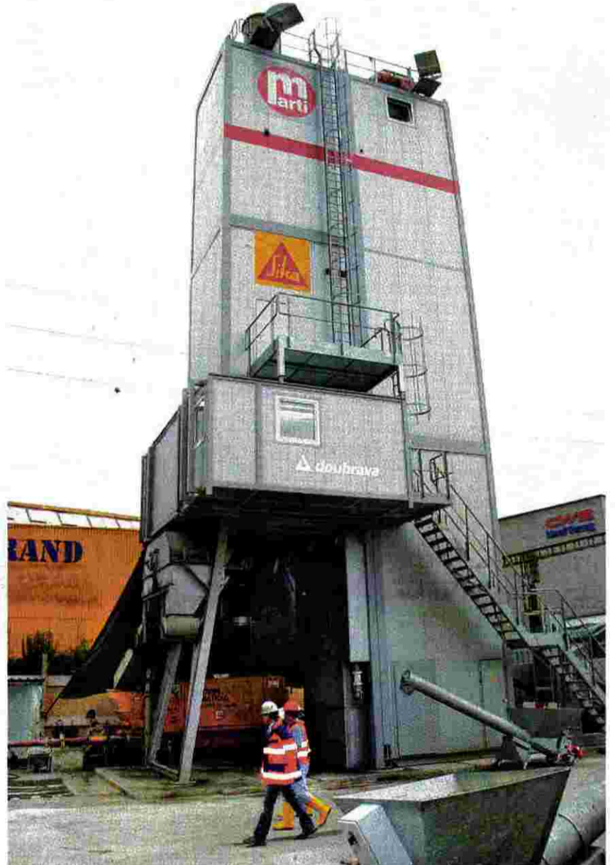
In diesem siloartigen Turm wird der Beton für den Stelzentunnel gemischt.
