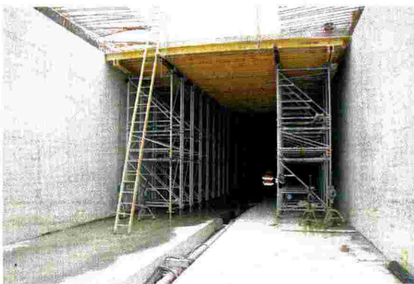
... davon sind bereits 250 Meter überdacht.
