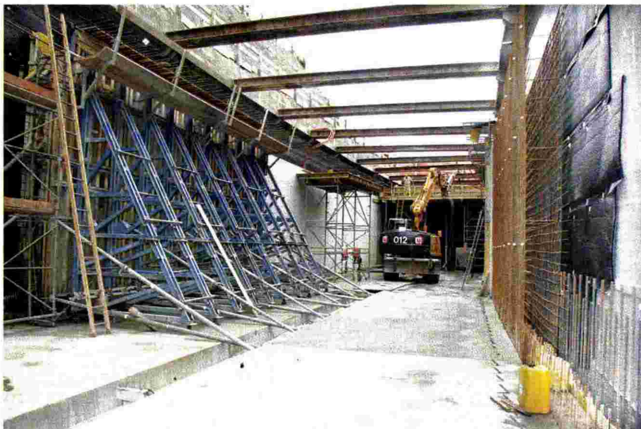
400 Meter wird der Stelzentunnel lang, ...
