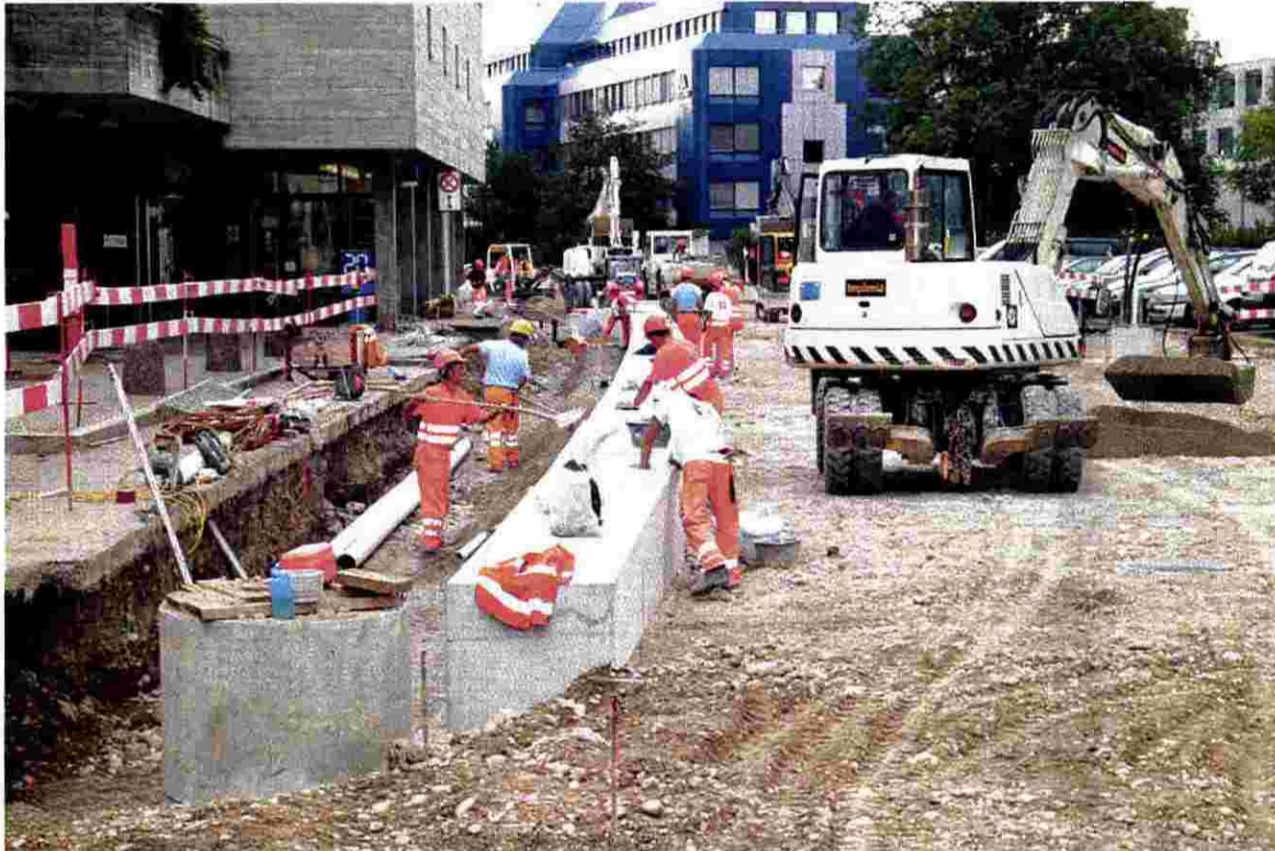
Bis zur Inbetriebnahme der Glattalbahnen müssen die Reisenden beim Bahnhof Glattbrugg noch einige Umwege in Kauf nehmen.
