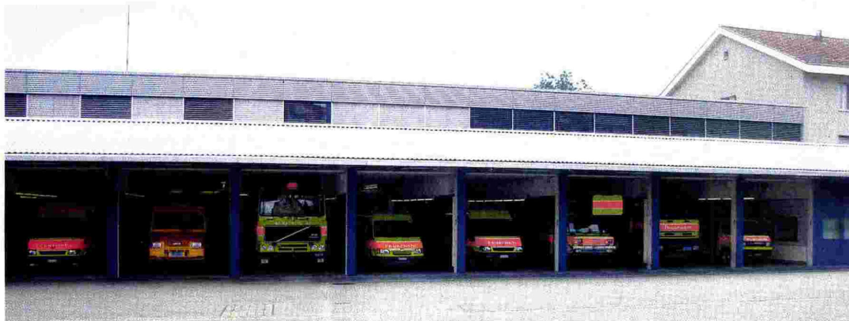
Für die Zukunft bestens gerüstet – die Stützpunktfeuerwehr Opfikon.
