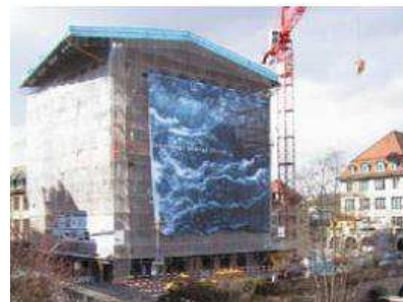
Windkräfte werden durch zusätzliche Verankerungen abgeleitet.
