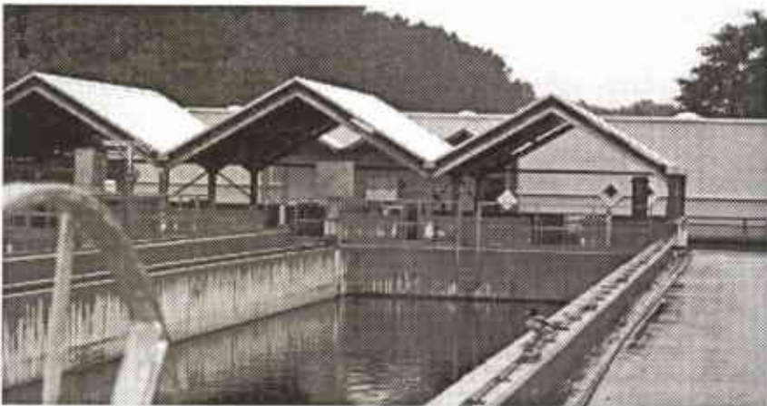
Die Kläranlage Kloten-Opfikon ist als eine der ersten Anlagen in der Schweiz zertifiziert worden. Wie auf dem Bild ersichtlich, gehören auch Enten zu den Gästen der Anlage.
