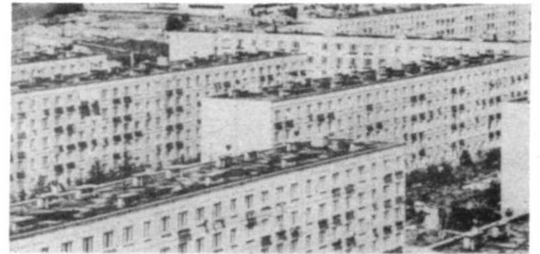
Ein Foto aus dem Tages-Anzeiger, welches das neue Cheryomuschkii-Wohnquartier in Moskau zeigt, aber ebenso auch in westlichen Städten anzutreffen ist. Bis zu 80 m lange und sechs Geschosse hohe Bauten wären nach neuer Bauordnung auch im Oberhauserriet möglich!
