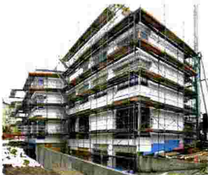
Der Rohbau an der Holbergstrasse aus heutiger Sicht. (zvg)
