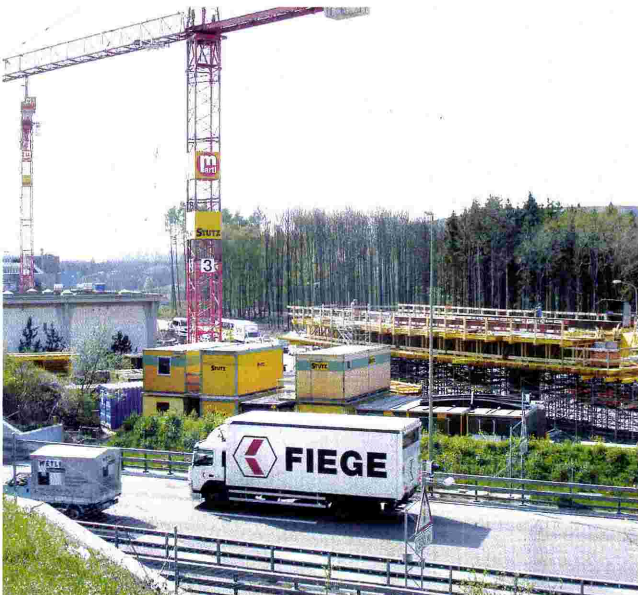
Blick von der SBB-Station Kloten-Balsberg auf das Trasse der Glattalbahn. Eine noch zu bauende Fussgängerbrücke schafft Umsteigemöglichkeiten in die beiden Bahnen auf gleicher Ebene.
