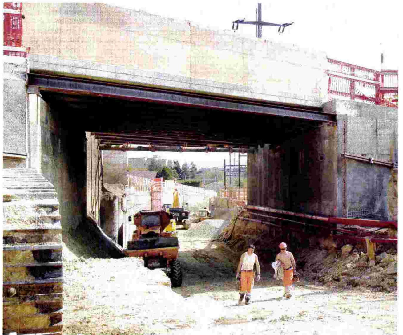
Die Zufahrt vom Stelzentunnel zum SBB-Bahnhof Glattbrugg.
