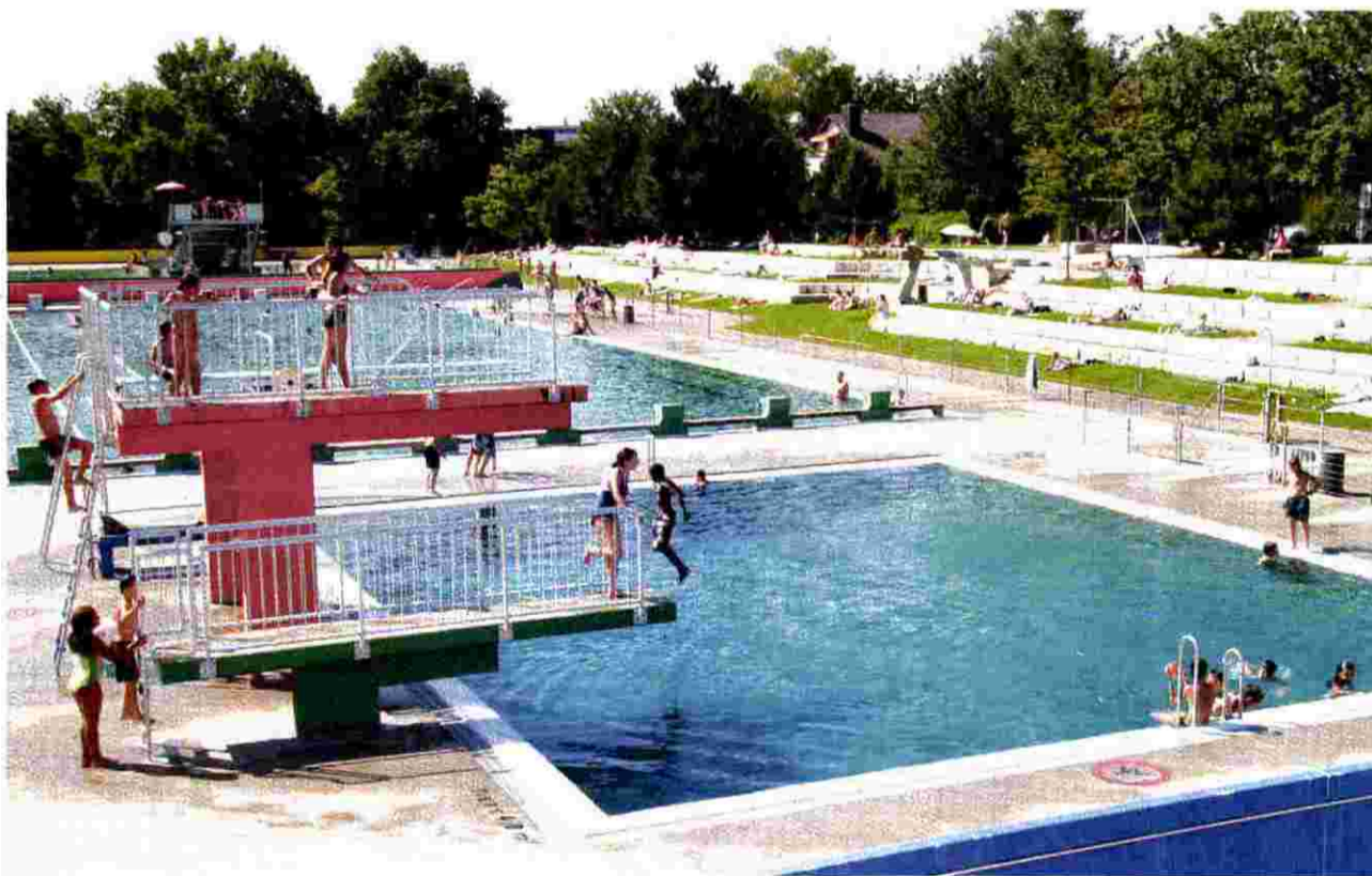
Die Badanlage Bruggwiesen ist sanierungsbedürftig.
