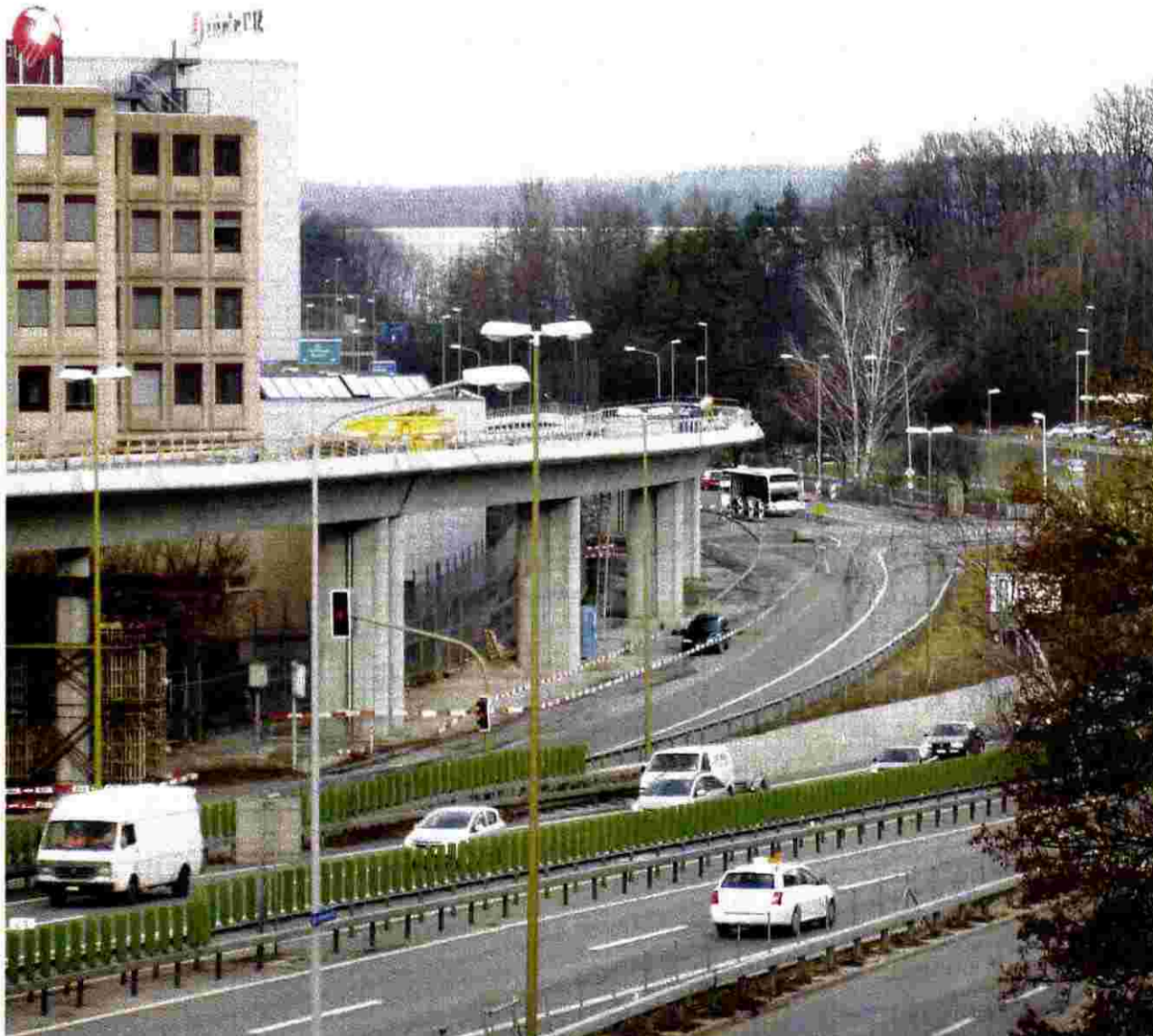
Mit dem Bau des Viadukts entlang des Werftareals in Kloten ist ein Kernstück der zweiten Etappe fertig.
