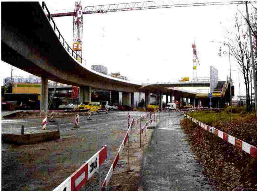
Zurzeit werden die Bauarbeiten im Bereich der Haltestelle Bahnhof Balsberg abgeschlossen.
