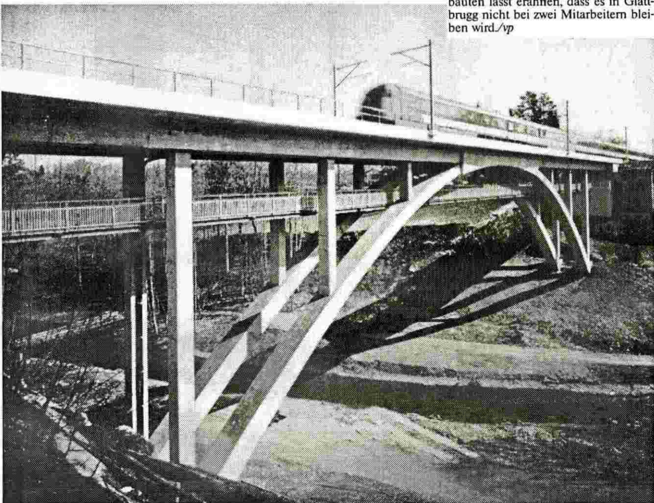
Brückenbau ist eines der Spezialgebiete des Unternehmens
