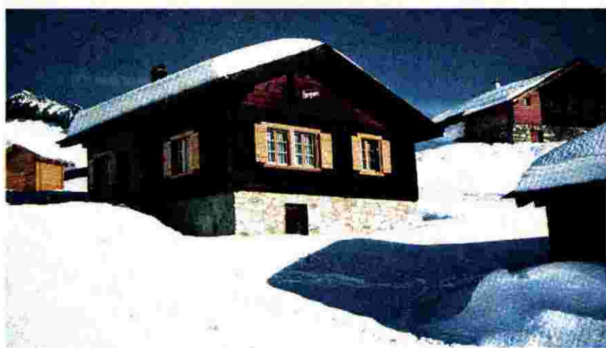
Beim Bau ihres Häuschens haben Trudy und Hugo Ruppen tatkräftig mitgeholfen
