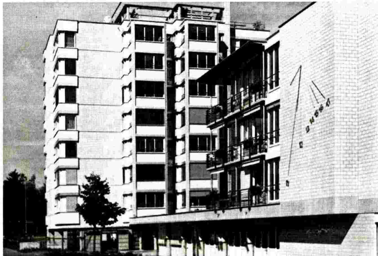
Letzte Bauetappe des Alterszentrums erfolgreich abgeschlossen
