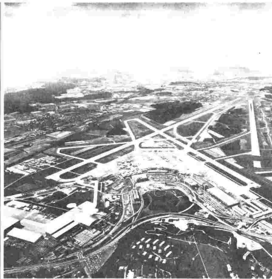
Bis zum 17. Juli ist die Westpiste eine gigantische Baustelle
