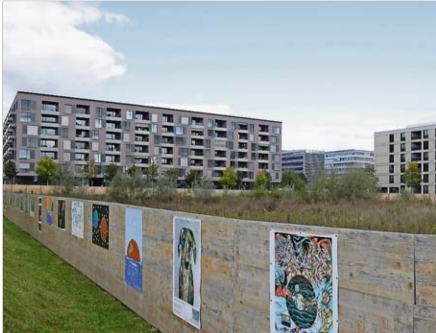
Hinter diesen Bauwänden, zwischen Boulevard Lilienthal, Blériot-Allee und Dufaux-Strasse, soll die neue Schule gebaut werden. Foto: mal.
