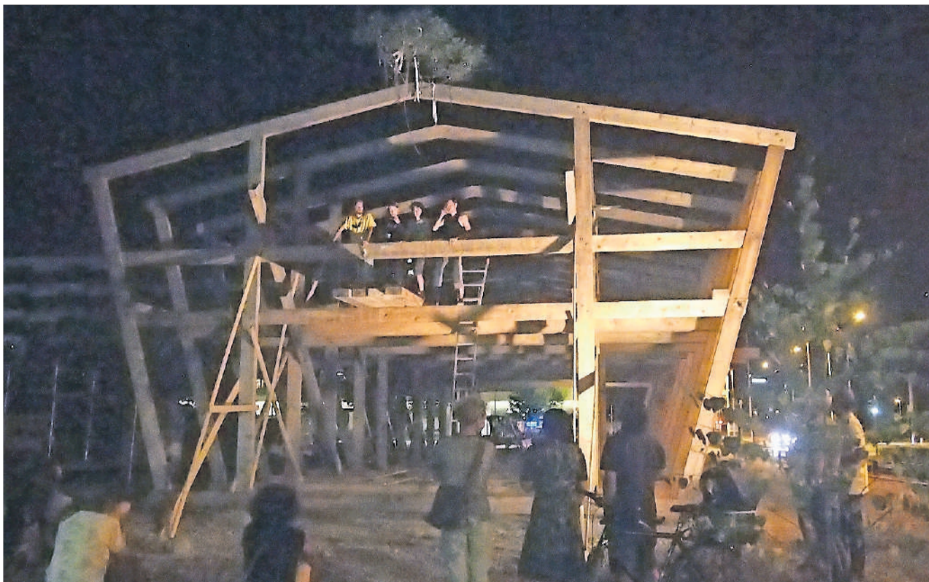
Am späteren Freitagabend feierten die Handwerker Aufrichte des Recycling-Pavillons.
