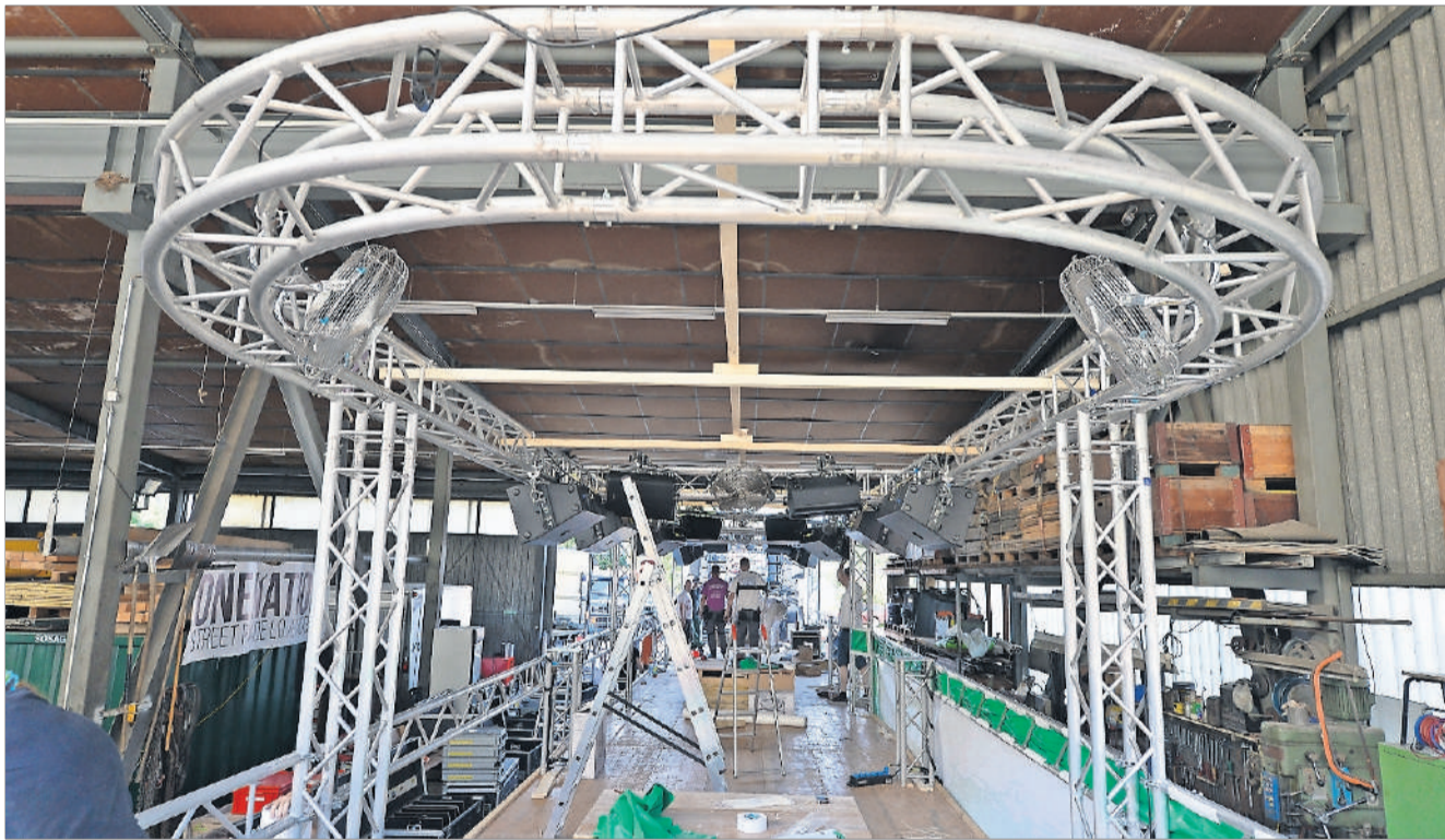
Einige Stunden nach Beginn der Aufbauarbeiten sind am Donnerstagnachmittag die Konturen des Lovemobiles bereits ersichtlich.
